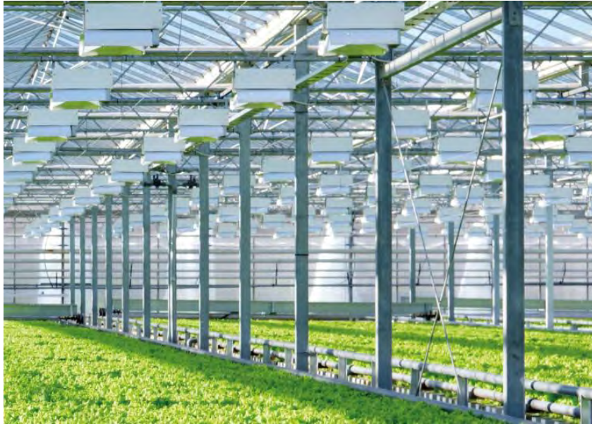
Рис. 4. Приклад встановлення ламп в теплиці
