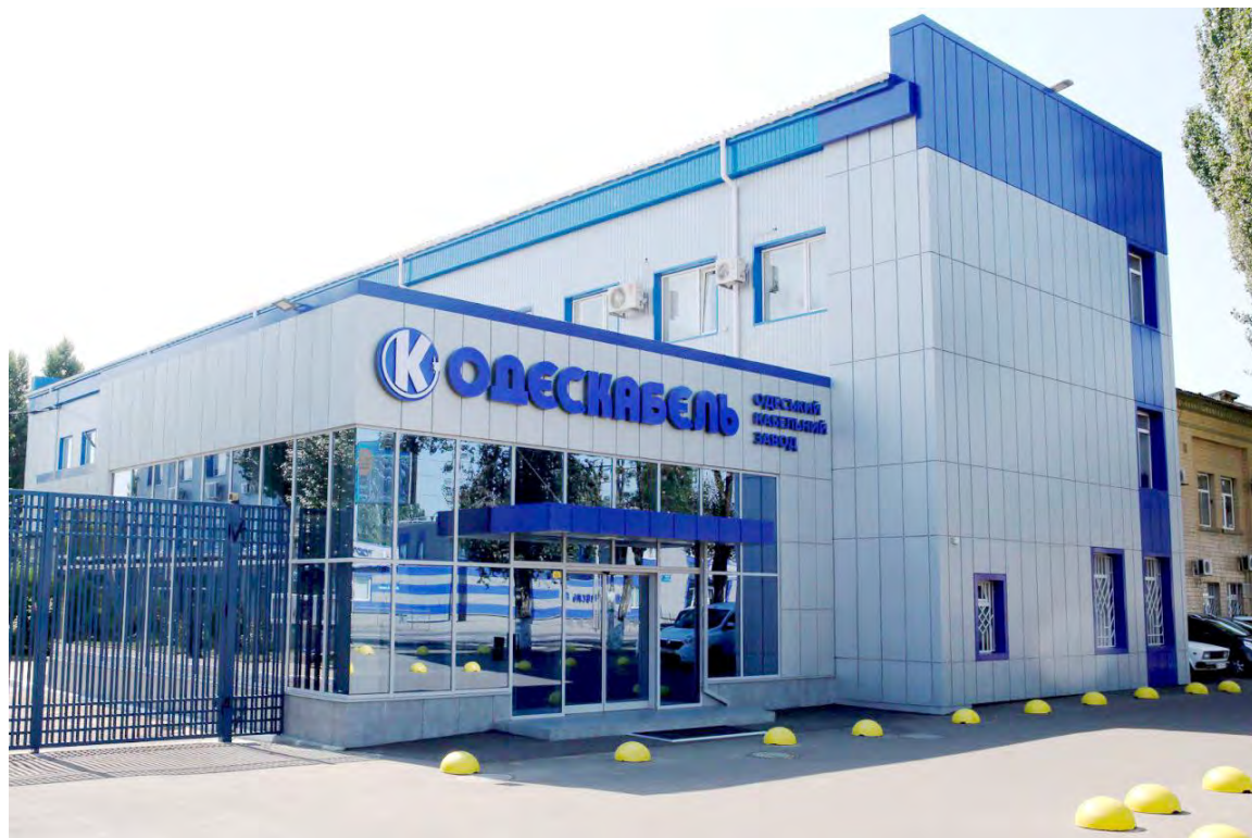
Рис. 1.6. Фасад головного входу «ОДЕСКАБЕЛЬ»
