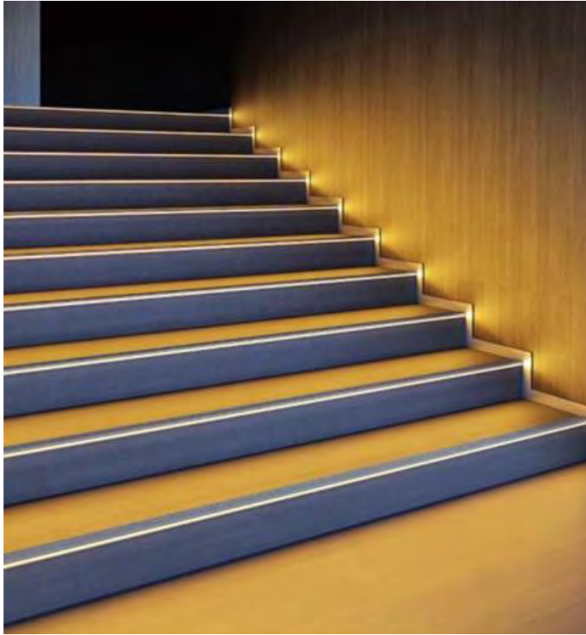
Рис. 1.9 - Освітлення збоку, або в кутку кожної сходинки, за допомогою світлодіодів, міжповерхових сходів.
