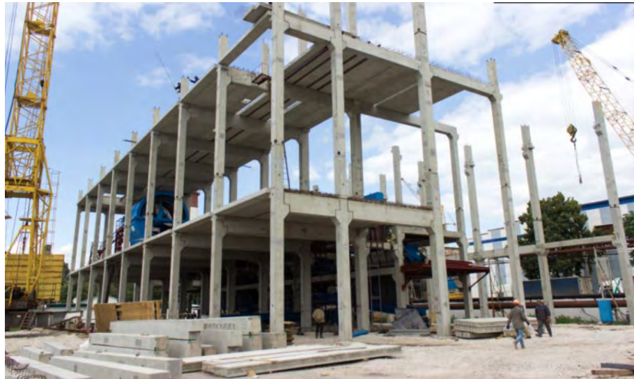
Рис.1.5. Зведений каркас збірних залізобетонних конструкцій
