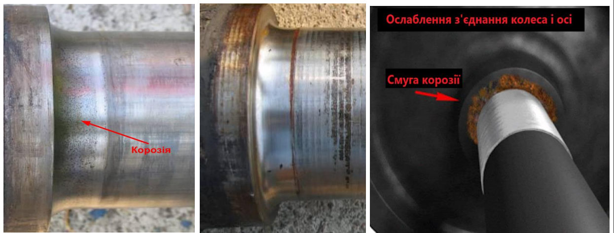
Рисунок 1.17. Корозійні пошкодження: а) в галтелі шийки осі, б) шийки осі, в) ослаблення з'єднання через смугу корозії
