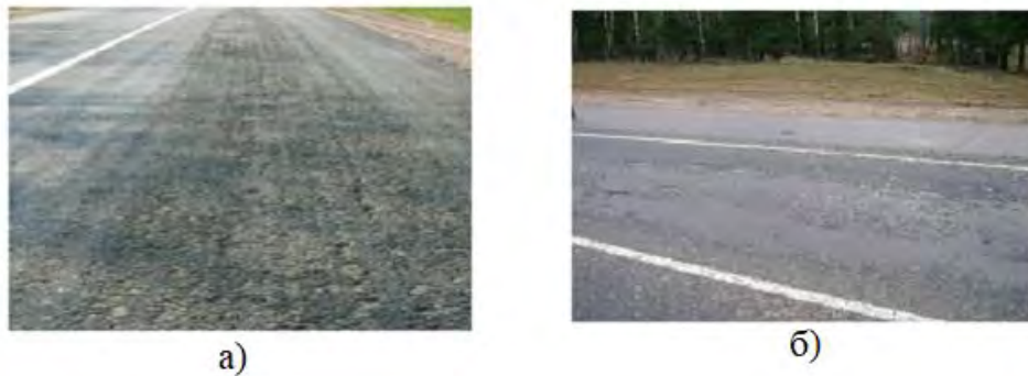
Рис.1.2.2: а) викришування, б) лущення
