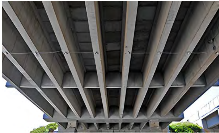
Рис. 1.18 - Встановлення В-WIM [15]
