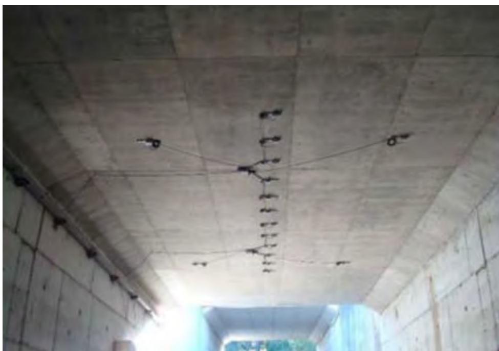
Рис. 1.16 - Встановлення В-WIM [21]
