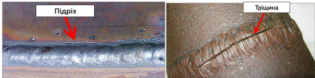
Рисунок 1.13. Дефект зварного з'єднання: підріз та тріщина
