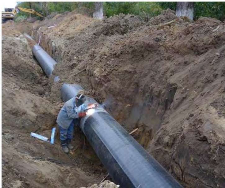
Рисунок 1.2. Ремонт магістрального водогону (Львівська область)
