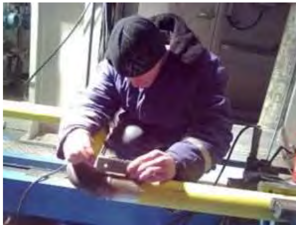
Рис. 1.14 Процес візуального контролю зварного з'єднання
