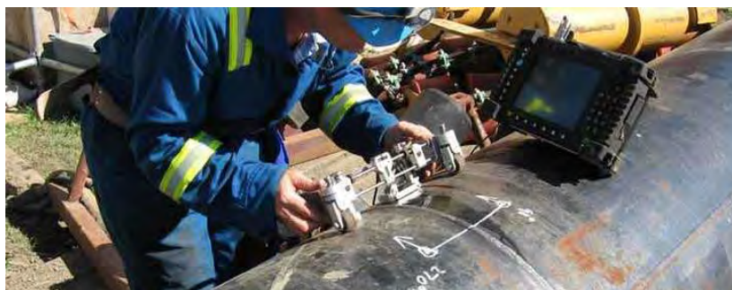
Рис. 1.16 Процес контролю зварного з'єднання
