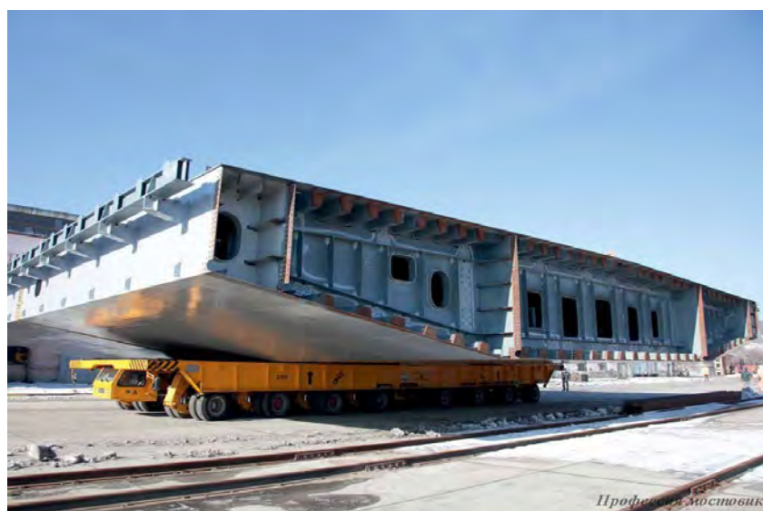
Рис.1.5 – Загальний вигляд ортотропних плит з'єднаних в один блок мосту
