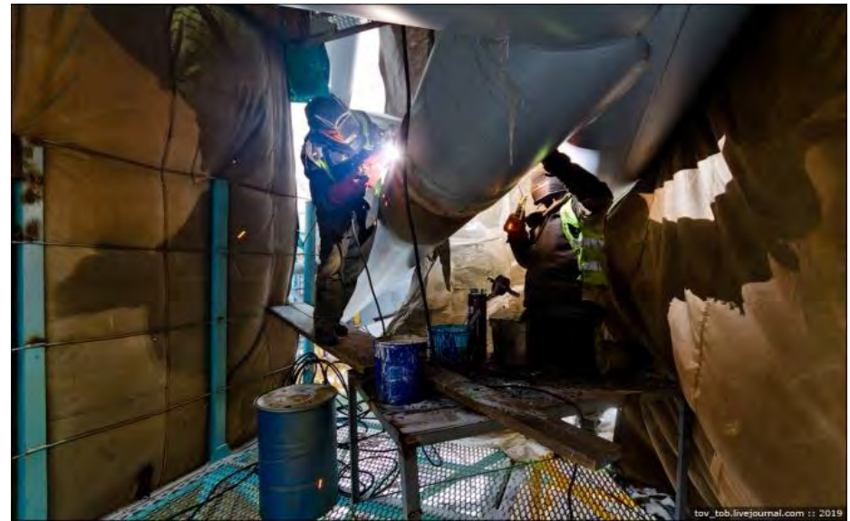
Приклад стикового з'єднання труб несучої конструкції мосту
