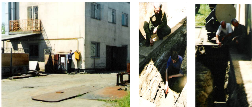
Рис. 2. Пошук газопроводу на заводській території приладом OPT.
